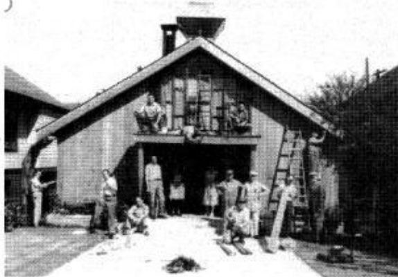
A második templom átépítése: toronyépítés, faborítás... stb. Our second church during renovation
